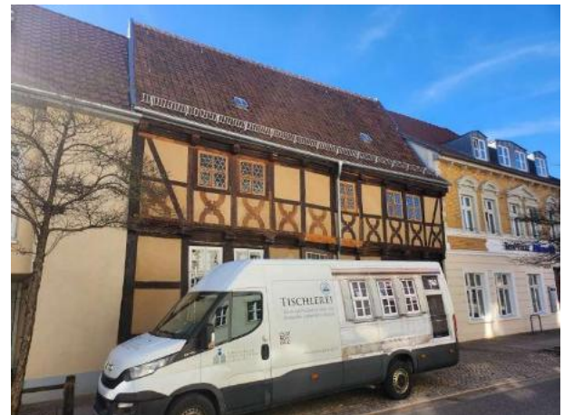
Einbau der straßenseitigen Fenster
