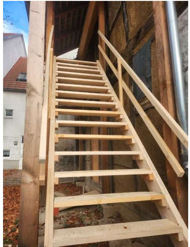
Vorübergehend installierte Bautreppe für ein besseres Handling der folgenden Gewerke
