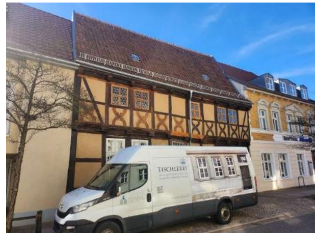
Einbau der straßenseitigen Fenster
