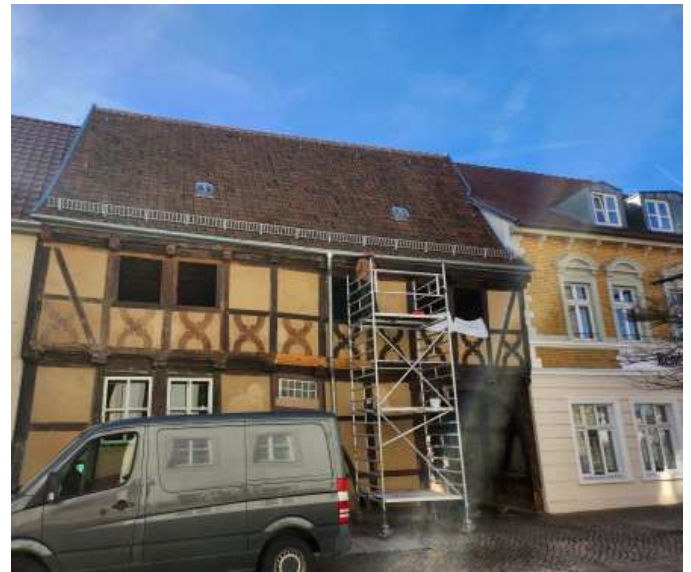
Grundierung des Fachwerks mit rohem Leinöl
