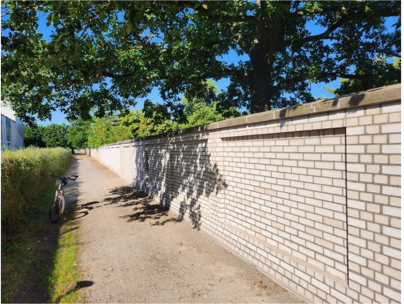
Abschluss der für das Jahr 2026 angesetzten Arbeiten im Juni
