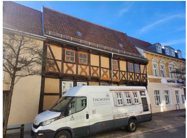
Einbau der straßenseitigen Fenster
