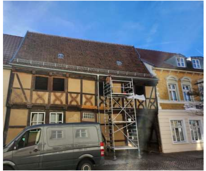
Grundierung des Fachwerks mit rohem Leinöl
