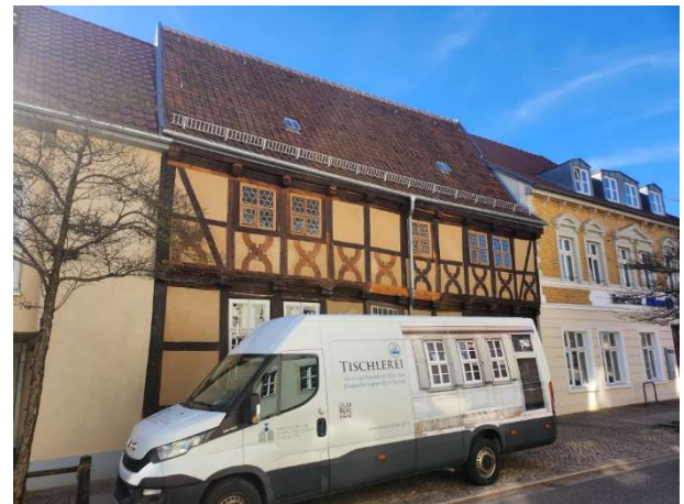
Einbau der straßenseitigen Fenster
