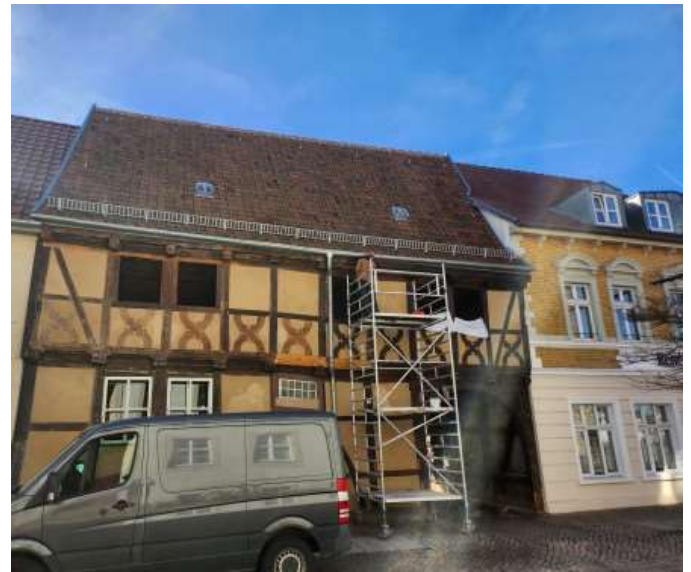
Grundierung des Fachwerks mit rohem Leinöl
