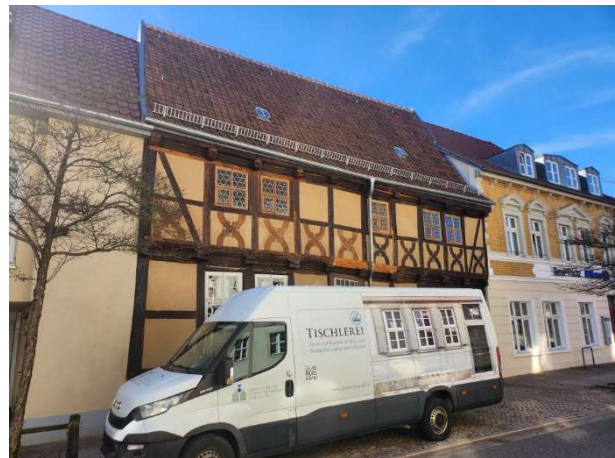
Einbau der straßenseitigen Fenster
