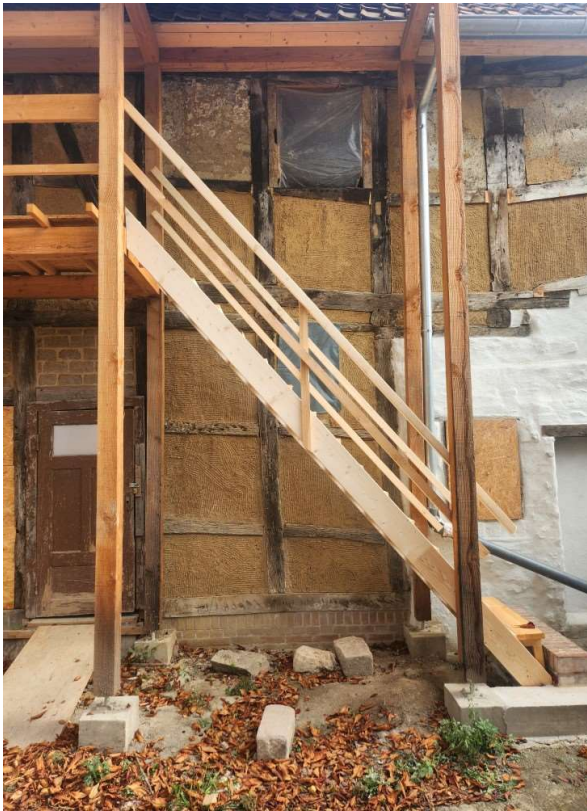
Vorübergehend installierte Bautreppe für ein besseres Handling der folgenden Gewerke
