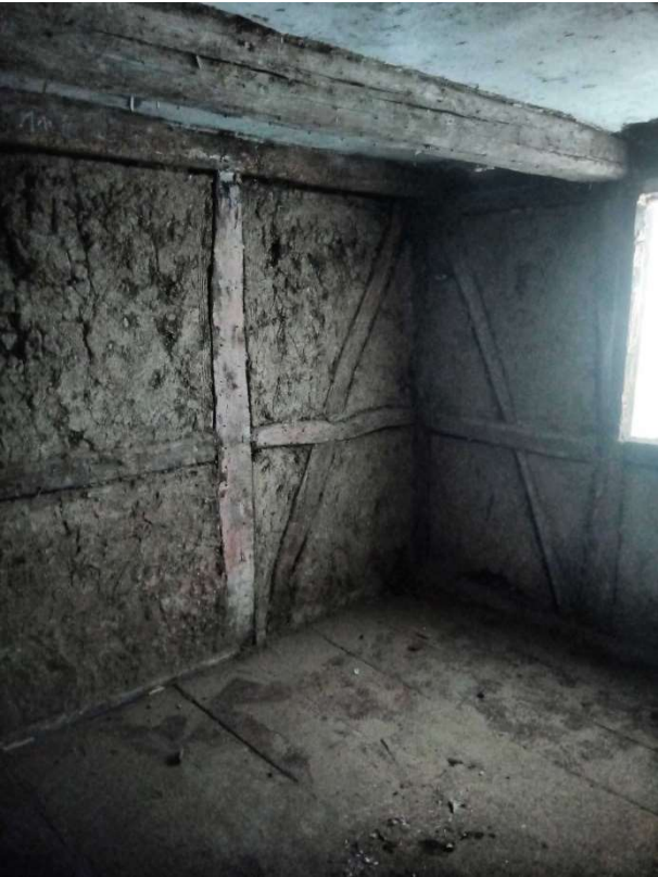
Alte Wickelstake aus der Deckenausfachung
