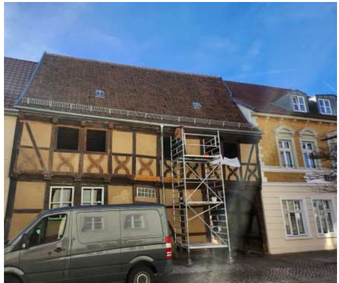
Grundierung des Fachwerks mit rohem Leinöl
