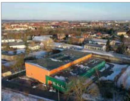
Die Sporthalle in der Zollstraße ist fertig.
