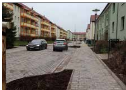
Die Rolandstraße wurde grundhaft ausgebaut.
