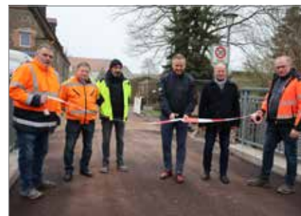
Die Beberbrücke wurde saniert und gesichert.
