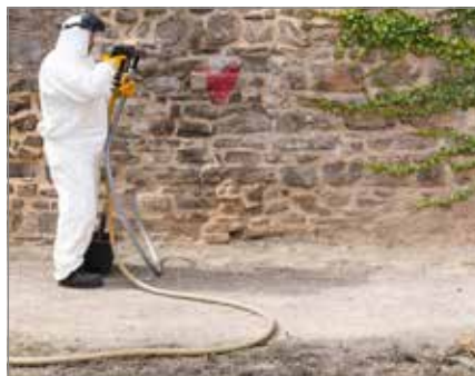
Eine Fachfirma beseitigte Graffiti an der Stadtmauer.
