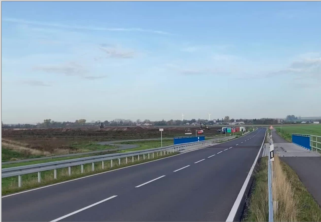
Foto 01 – Blick auf L42 in Richtung Wedringen mit dem geplanten Logistikstandort linksseitig zur L42; © IBB, Oktober 2022
