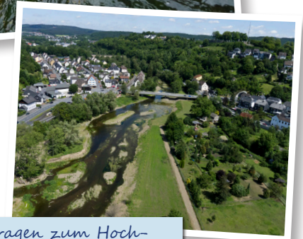
...tragen zum Hochwasserschutz und zur Artenvielfalt bei.
