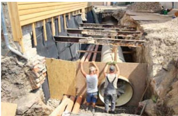
Bevor Beton in den Graben gegossen wird, muss verschalt werden
