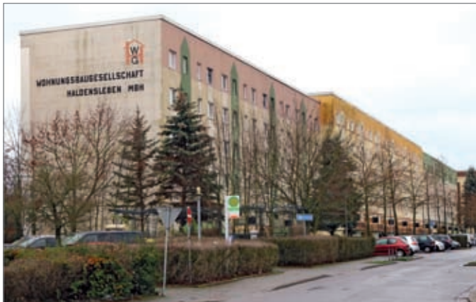
Ein Blick auf die drei Wohnblöcke am Waldring, die in diesem Jahr saniert werden sollen.
