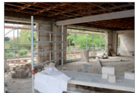
Die Kita Regenbogen wurde komplett entkernt und wird aufwendig umgebaut.
