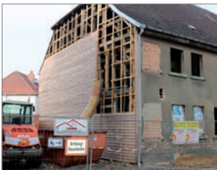
Das Haus an der Magdeburger Straße bekommt u.a. neue Fußböden und neue Decken.
