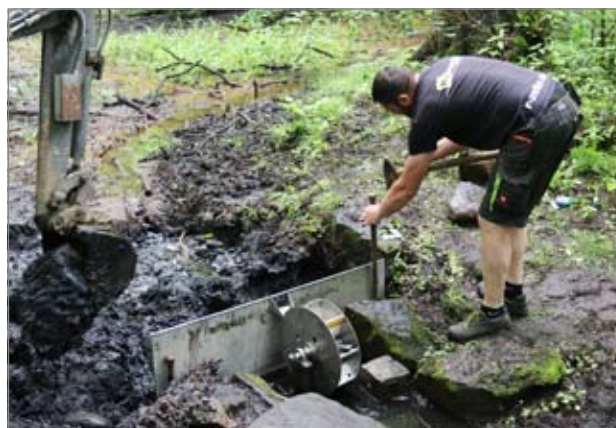
Christian Reinecke beim Einbau der neuen Stahlplatte
