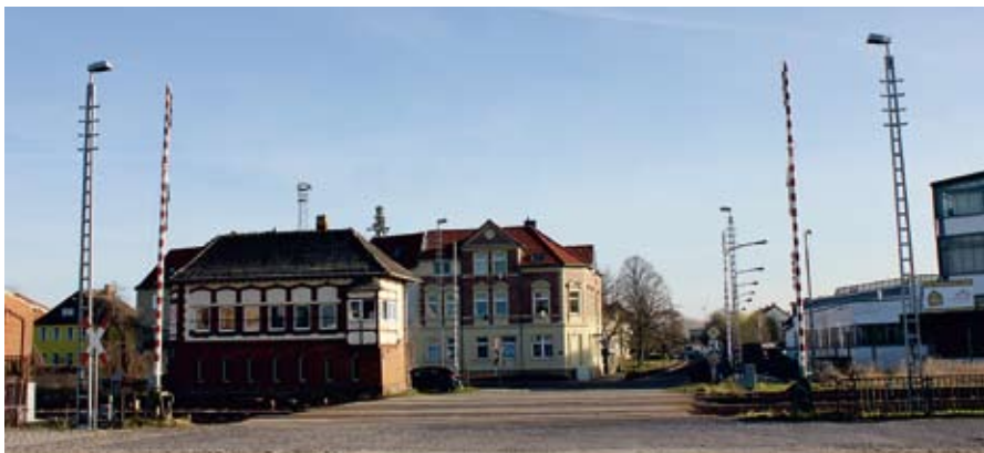
Der Bahnübergang Töberheide wird durch eine Radfahrer- und Fußgängerbrücke ersetzt.
