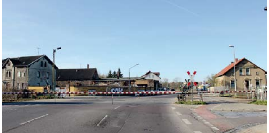
Der Bahnübergang Hagenstraße wird durch einen Tunnel für Pkw, Radfahrer und Fußgänger ersetzt. Lkw bleiben an dieser Stelle draußen.
